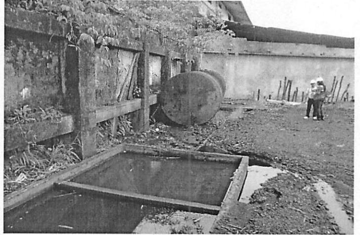
Tanques sedimentadores con capacidad insuficiente de almacenamiento, generando inundación.
